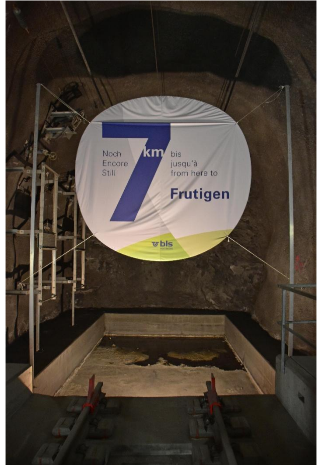
Da müssen noch 7 km gebohrt werden...
