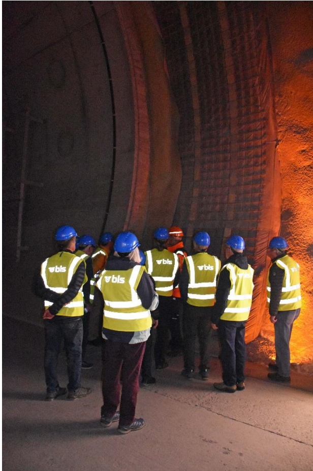
Hier sahen wir den Aufbau der Wandverkleidung
