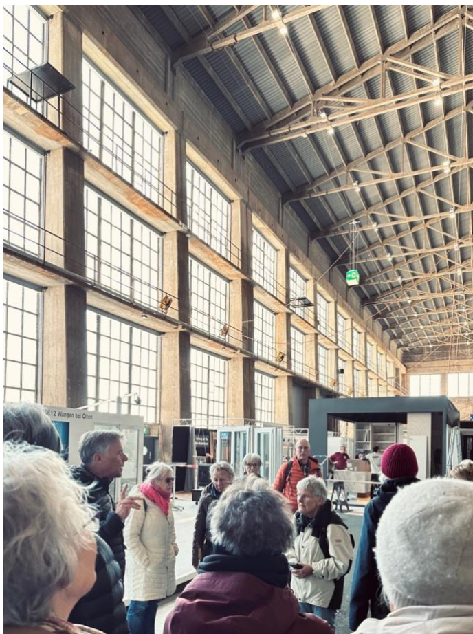
Unter Denkmalschutz: Riesige Halle mit feiner Eisenbeton-Konstruktion
