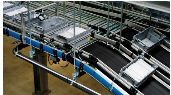
Fördertechnik mit Briefbehältern
