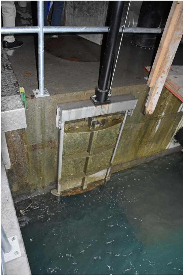
2017 wurde eine Fischschleuse eingebaut
