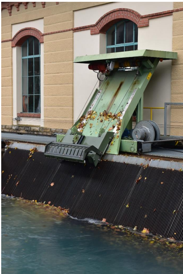
Der Rechen hält das grobe Material im Wasser zurück (momentan wird viel Laub rausgefischt)
