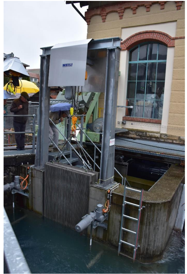
2017 wurde eine Fischschleuse eingebaut
