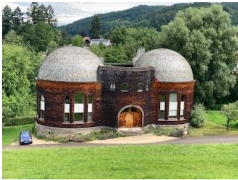
Glashaus (Glaserei). Gleicht dem ersten Goetheanum von 1914, das abgebrannt ist. Der Neubau erfolgte 1928.
